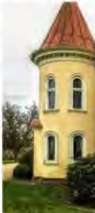
Jannebergs gård. "Vid ombyggnad två fristående tornen som omger verandan på framsidan." FOTO: LENA BERG
