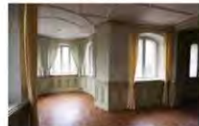
Rummet närmast köket har stukatur i taket, bröstpanel runt om och på golvet ligger en sliten plastmatta.
